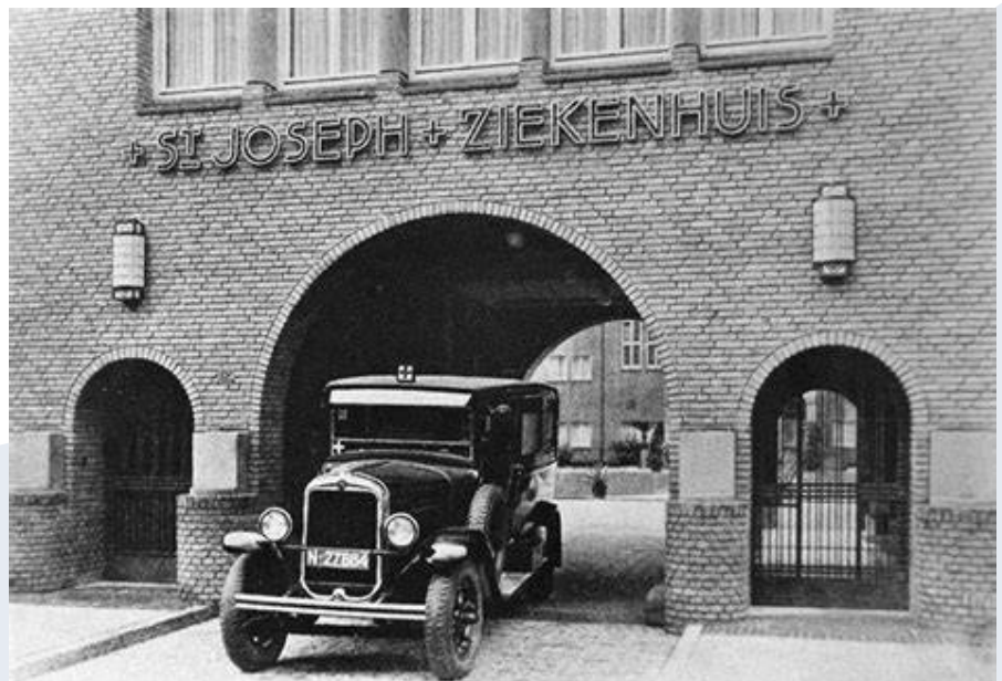
Figuur 2. Een ambulance rijdt weg bij het oude Sint-Joseph ziekenhuis aan de Aalsterweg in Eindhoven.
