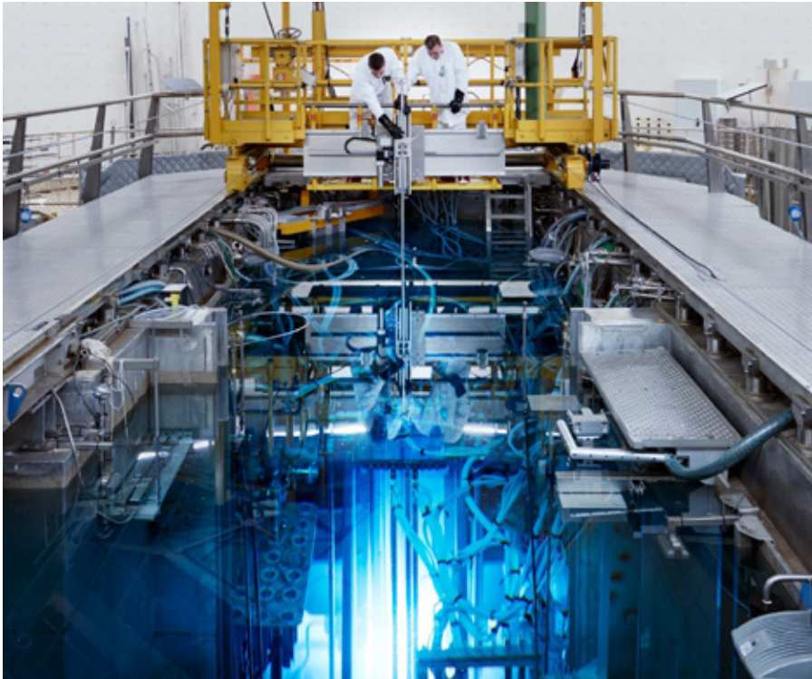
De reactorkern in het waterbad van de High Flux Reactor in Petten, inclusief het blauwe licht van de Cherenkov-straling (bron PALLAS).
